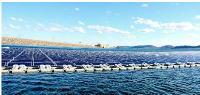
Projeto da Chesf busca analisar a eficiência das usinas fotovoltaicas flutuantes. Foto: André Schuler/Chesf
