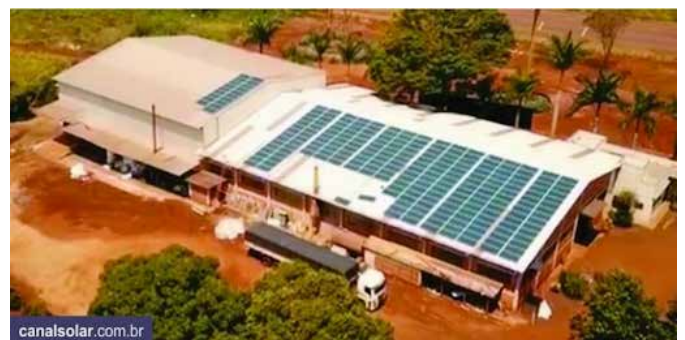
Figura 7: Exemplo de cobertura do galpão. Fonte: Canal Solar (2019)
