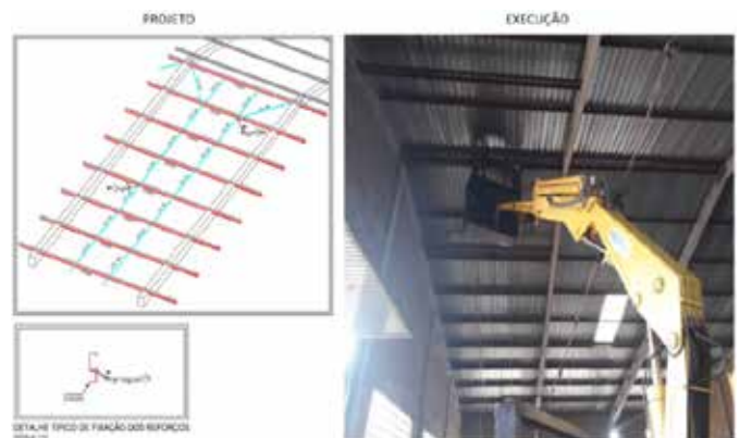
Figura 4: Exemplo de reforço realizado nas terças de um telhado de estruturas metálicas. Fonte: Canal Solar (2021)
