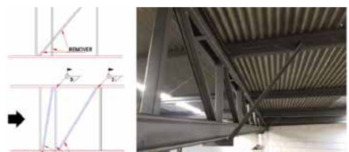
Figura 5: Exemplo de reforço realizado nas tesouras de um telhado de estruturas metálicas. Fonte: Canal Solar (2021)
