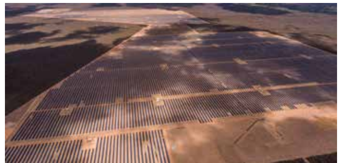
Usina de Nova Olinda, no Piauí. Foto: Enel Green Power
