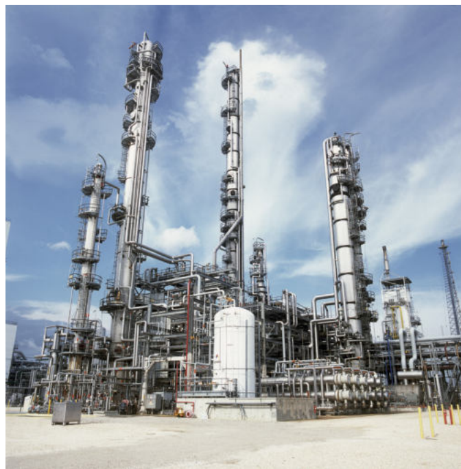
A instalação de produção de hidrogênio da Air Products em Port Arthur, Texas, fornece hidrogênio de alta pureza para a conversão de petróleo bruto pesado em gasolina de combustão mais limpa e diesel com baixo teor de enxofre. Foto: Air Products/Divulgação
