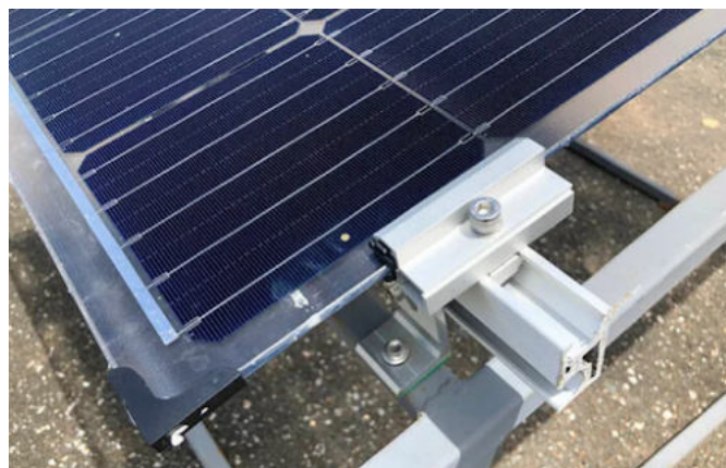
Figura 4: Exemplo de módulo vidro-vidro monofacial. Fonte: Arquivo do autor
