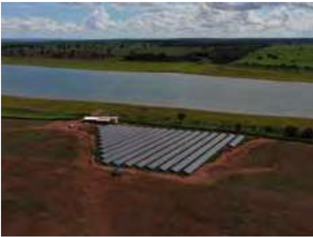
Usina fotovoltaica de 773 kWp instalada na fazenda. Foto: Canal Solar
