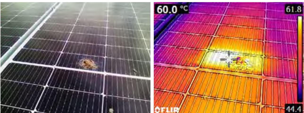
Figura 5: Ponto quente causado por dejetos de animais. Foto: Canal Solar
