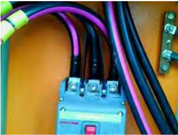
Figura 6: Ponto quente causado por conexão frouxa no disjuntor CA do inversor. Foto: Canal Solar
