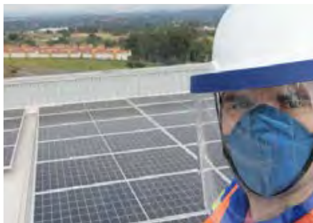
Marcelo Villalva em campo vistoriando uma instalação fotovoltaica. Foto: Facebook/Reprodução
