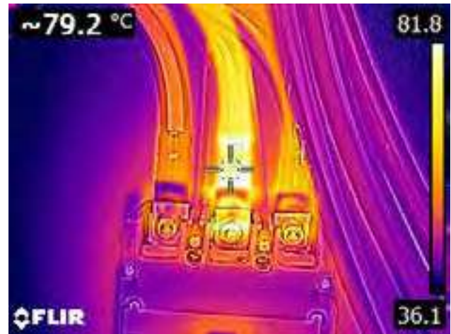
Figura 6: Ponto quente causado por conexão frouxa no disjuntor CA do inversor. Foto: Canal Solar
