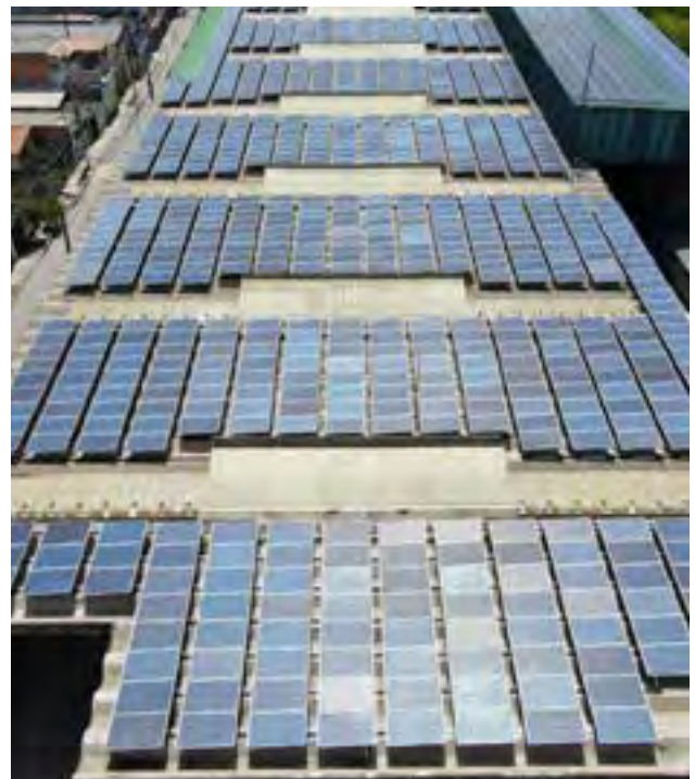
Diferença do espaçamento dos módulos fotovoltaicos, antes e depois das correções, é nítida por meio de imagens aéreas
