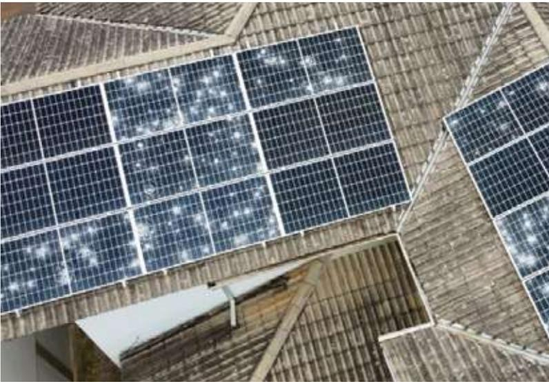
Pedras de granizo danificam painéis solares Foto: Elétron Seguros
