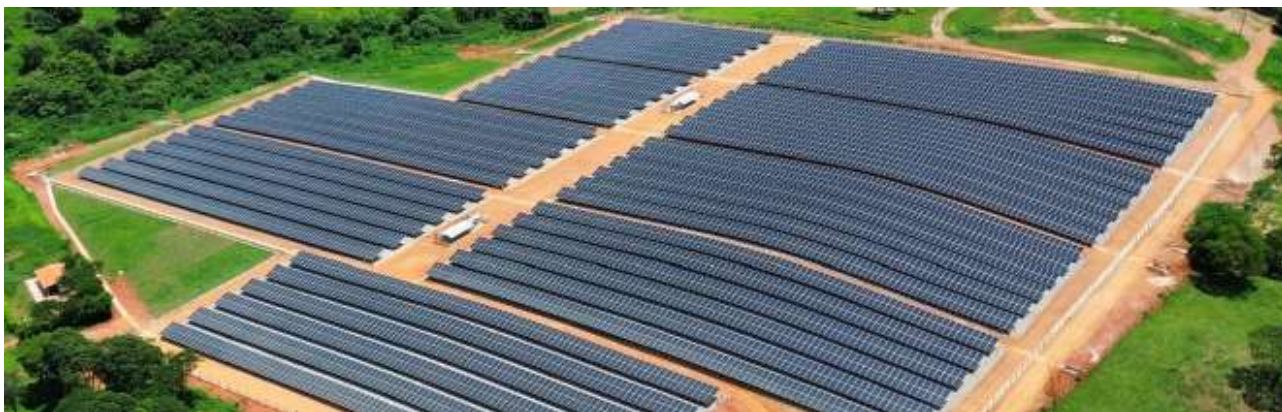
Usina fotovoltaica da empresa possui 5,7 MWp. Imagem: SSA/Divulgação
